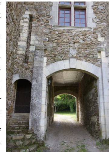
Trace conservée du passage de la flèche du pont-levis de l'entrée piétons
